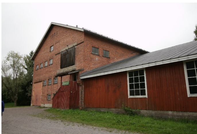
Tiiliuunin suojarakennus ja konehalli vuodelta 1946. Rakennus on suojeltu.
